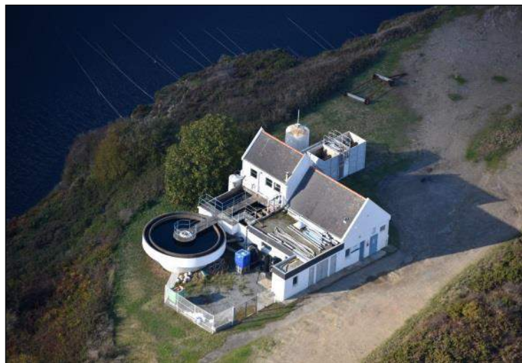
Station de traitement de Port Melin (photo GEOS)
