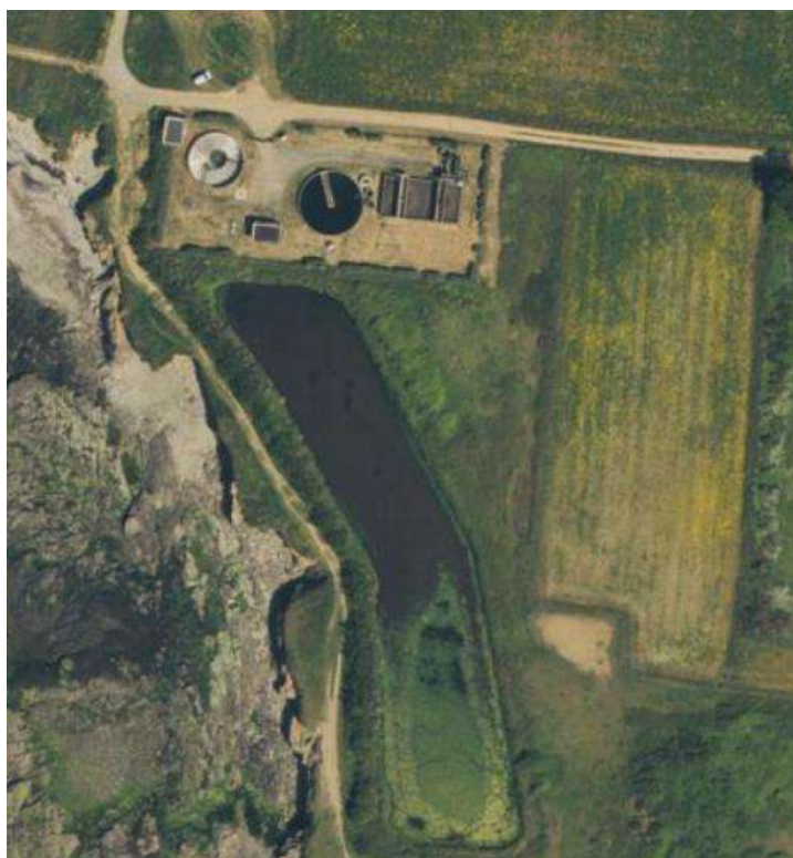
Figure 27 : Photo aérienne de la STEP de Locmaria - Source : Géoportail
