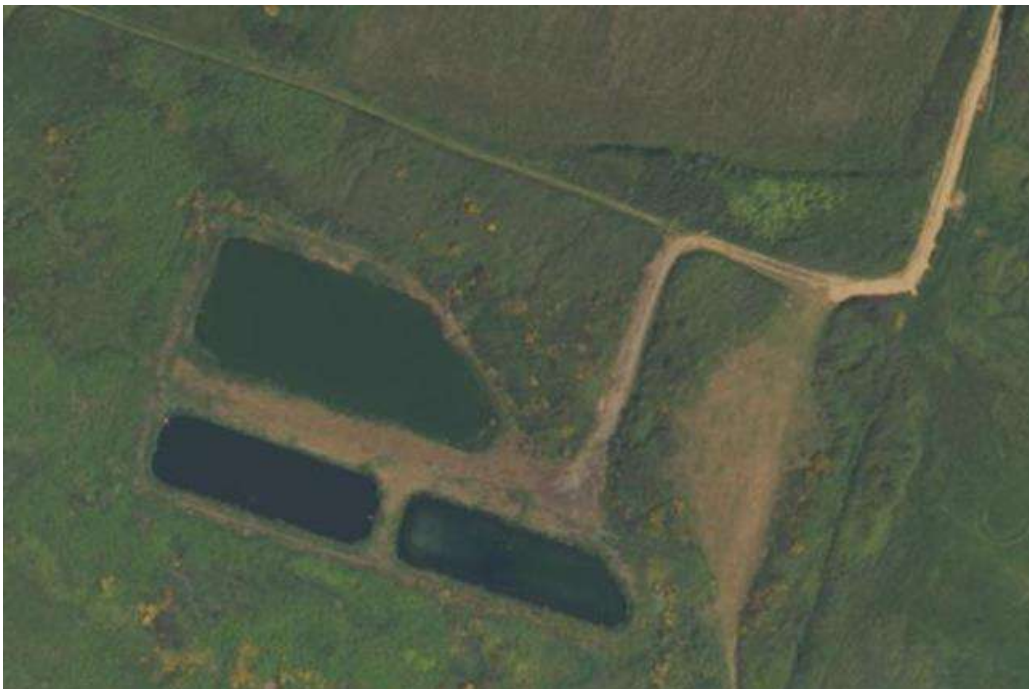
Figure 32 : photo aérienne de la STEP de Kerlard - Source : Géoportail
