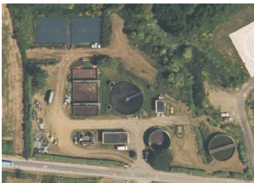
Figure 25 : Photo aérienne de la STEP du Gripp - Source : Géoportail
